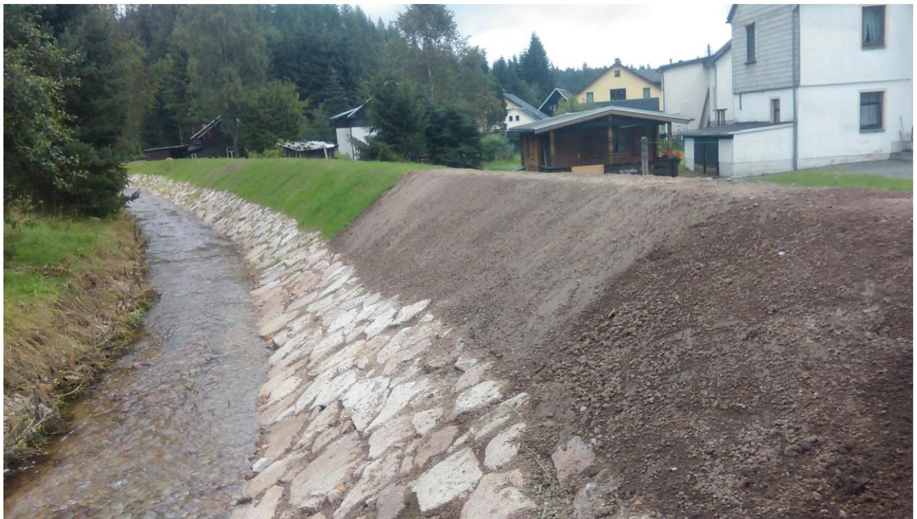
Uferverwallung mit Deckwerk aus Wasserbausteinen rechts und Flechtwerk links
